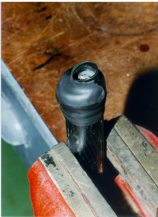
Páska 2228 navinutá na konec kabelu AXEKCEY
